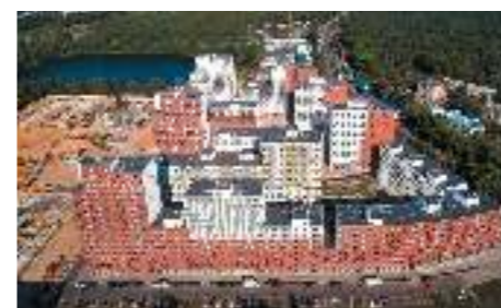
ЖК «Новокрасово», МО «Тройка РЭД»
